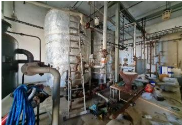
Obrázek 11 : Plynový kotel pro dohřev teplé vody v akumulčních nádržích, akumulční nádrže teplé vody
