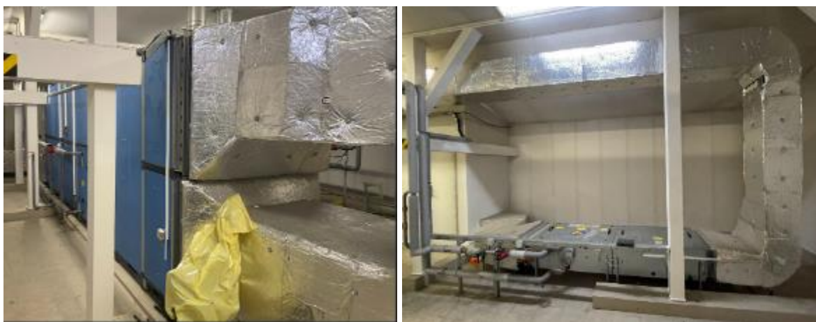
Obrázek 35 Vzduchotechnika pro stravovací provoz
