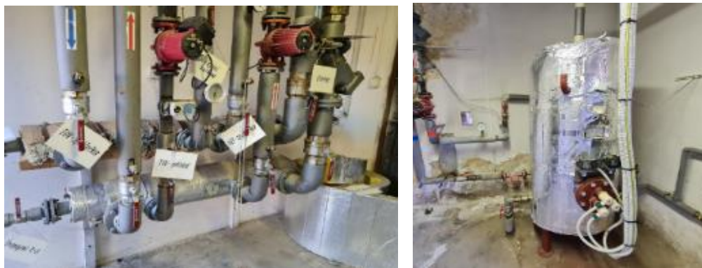
Obrázek 21 : Rozdělovač topné vody v regulační stanici č.5 Kuchyně, příprava teplé vody
