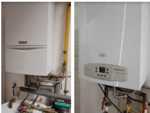
Obrázek 12 plynový kotel Vaillant – lékárna, plynový kotel BAXI - vrátnice
