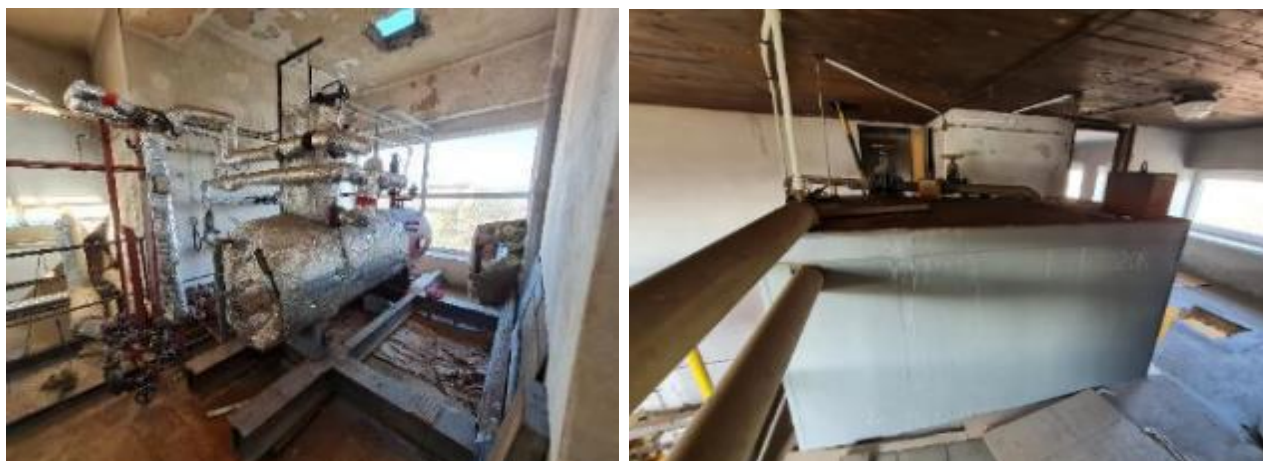
Obrázek 9 : Napájecí nádrž umístěná v 2.NP, záložní napájecí nádrž umístěná ve 3.NP
