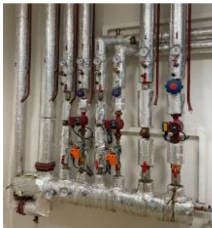
Obrázek 22 Rozdělovač topné vody v RS č. 6 – HTO
