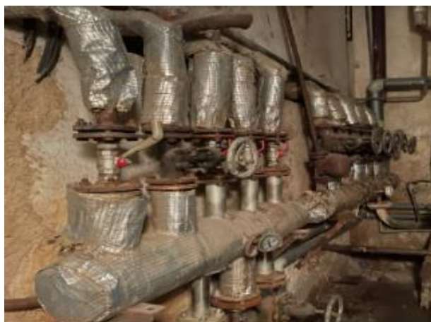
Obrázek 17 : Rozdělovač teplé vody v 1.PP kotelný
