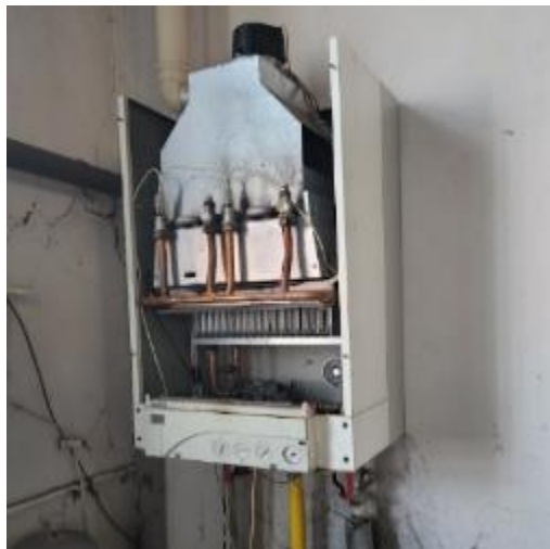
Obrázek 11 : Plynový kotel pro dohřev teplé vody v akumulčních nádržích, akumulční nádrže teplé vody
