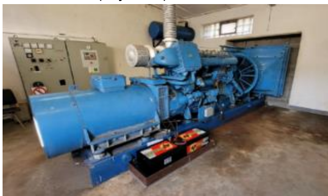
Obrázek 26 Záložní zdroj energie - dieselaagregát
