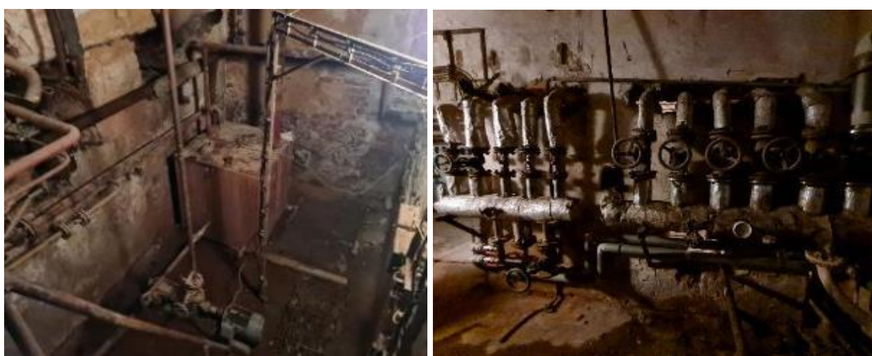
Obrázek 10 Sběrná kondenzátní nádrž v suterénu kotelny (1.PP), za stěnou rozdělovač teplé vody
