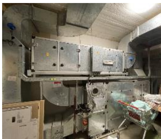
Obrázek 33 Vzduchotechnika VTZ č. 6 – JIP, umístěna v suterénu lůžkové části nemocnice
