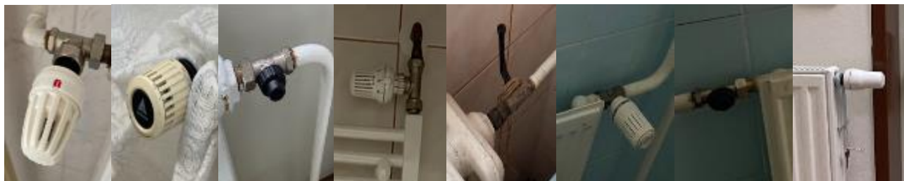
Obrázek 24 Radiátorové hlavice otopných těles Rokycanské nemocnice
