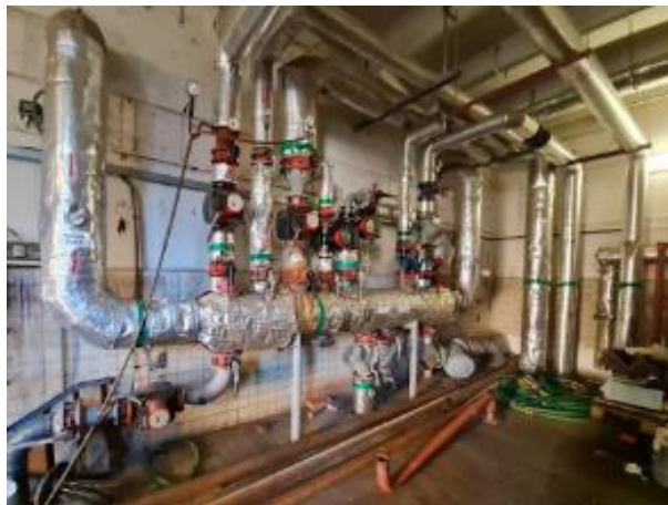
Obrázek 16 : Rozdělovač topné vody vedle místnosti hlavní kotelny
