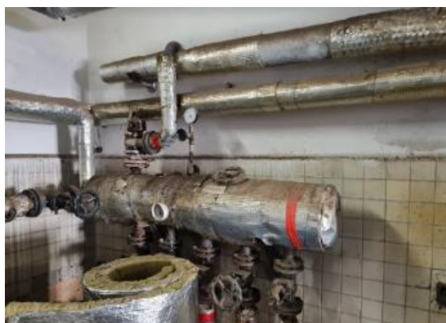
Obrázek 14 : Parní rozdělovač 0,05 MPa
