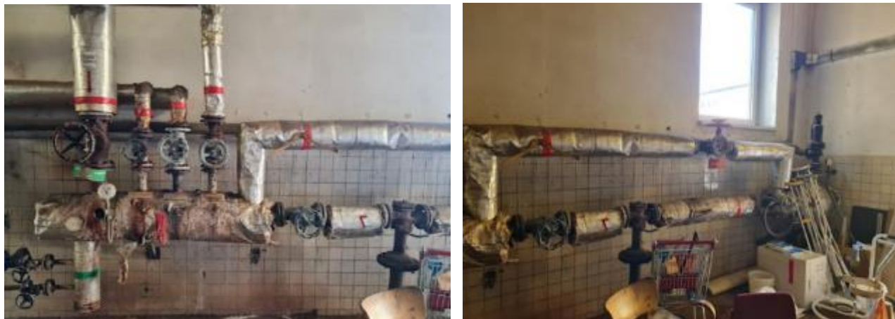
Obrázek 13 : Parní rozdělovač 0,8 MPa a redukce páry na 0,25 MPa pro ohřev TV akumulační nádrže
