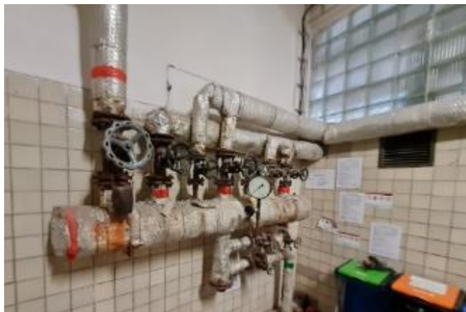
Obrázek 15 : Parní rozdělovač prádelna 1PP
