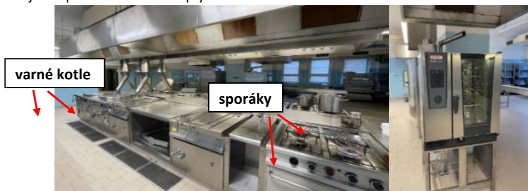
Obrázek 39 Plynové spotřebiče stravovacího provozu (kotle, sporáky, konvektomat).
